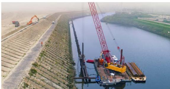
FIGURE 2 : MISE EN ŒUVRE DES PALPLANCHES PAR VOIE FLUVIALE
