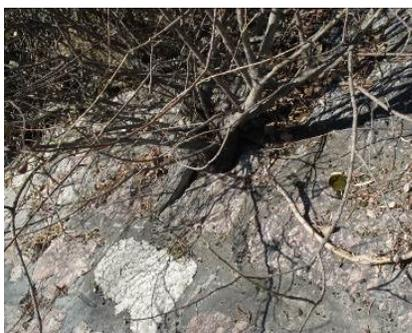
FIGURE 1 : DESTRUCTURATION EN COURS D'UN PERRE MAÇONNE PAR UN PEUPLIER AYANT ETE RECEPE PLUSIEURS FOIS.
